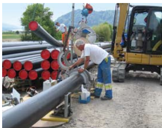
Soudage de tubes de 15 m Ø 355
