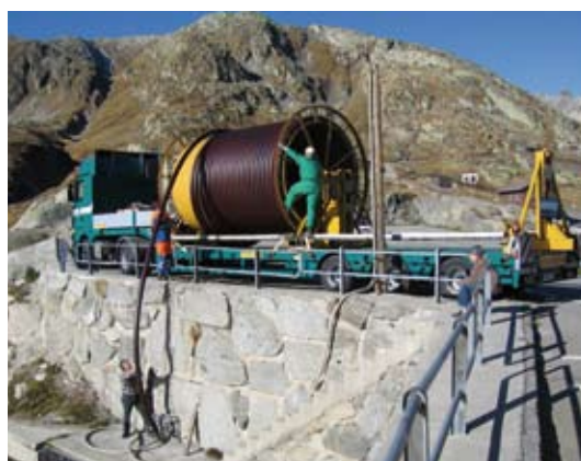
Pose de tubes sur tambours
