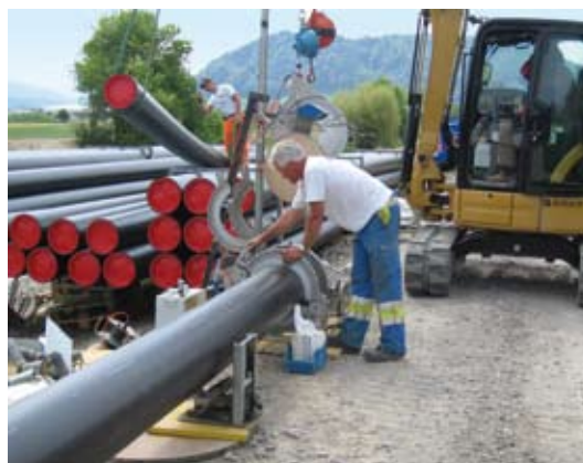
Verschweissung von Rohren 15 m Ø 355
