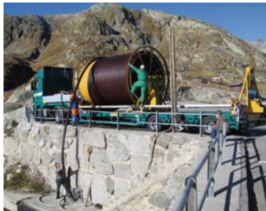
Rohrverlegung ab Haspel
