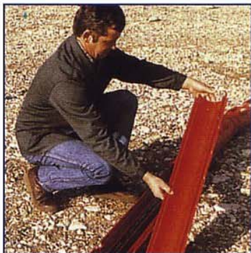
Pose de l'élément de base
