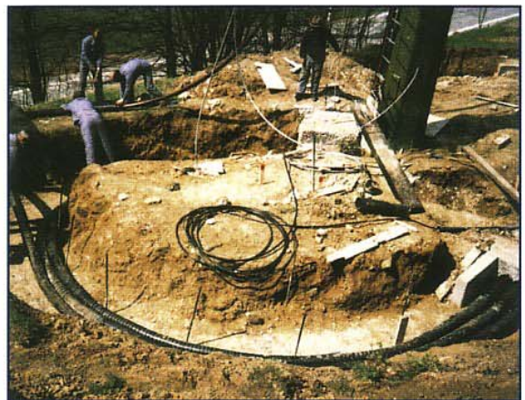
Pose de longueurs spéciales, le câble étant introduit préalablement de façon rectiligne
