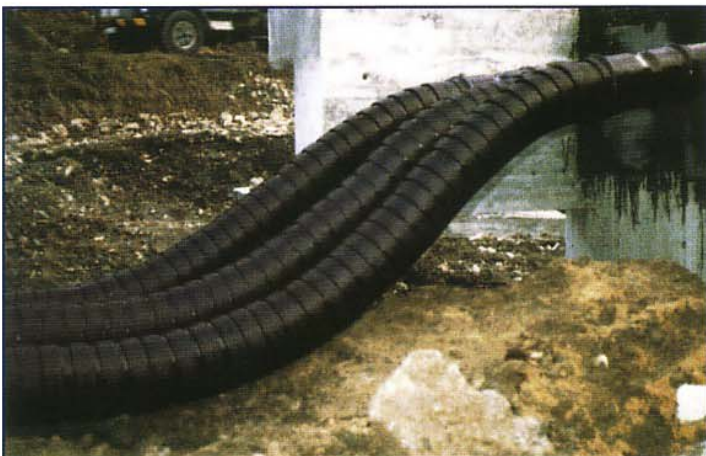
Déviation d'une conduite de câbles de la route dans le sol, protection contre le gel
