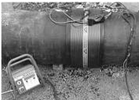
Abb. 5.13: Rohrverbindungen (PE) mit Elektro-Schweissmuffen mit systemgemässen Schweißgeräten
