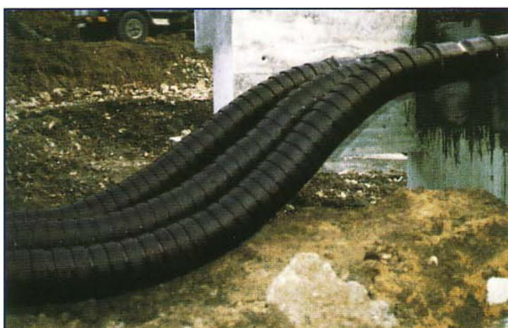
Brückenabgang von Fahrbahn- platte in frostsichere Grabentiefe
