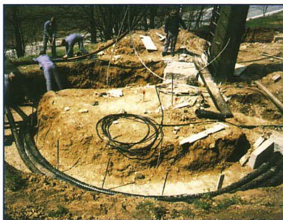
Verlegung von Sonderlängen, mit vorgängigem geraden Kabeleinzug
